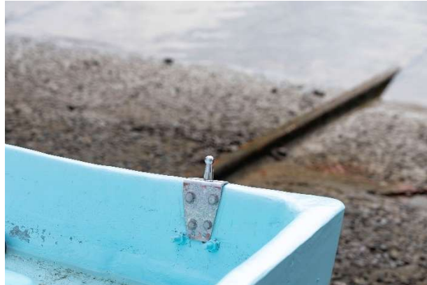
艀ぐいを設置し完成
