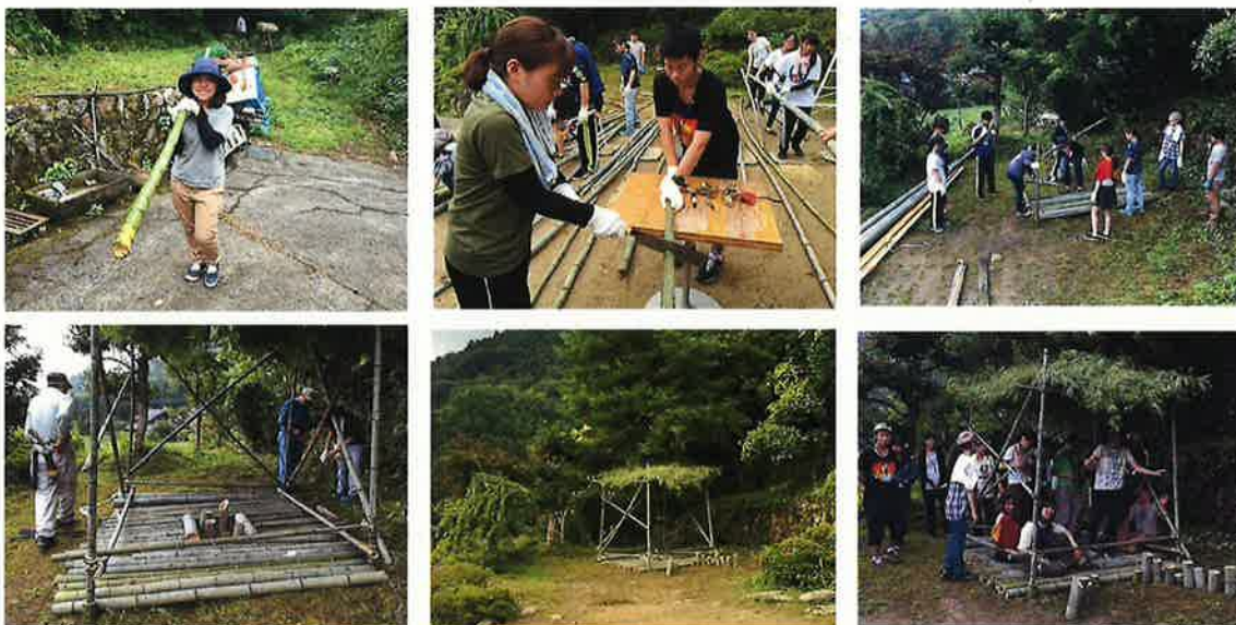
事前WS1：神山学舎のインスタントパーク型フューチャーセンター(KIPFC)でプロトタイプングする様子 (大学生と近隣住民の共創で地域資源「竹」を使い「あるものでつくる」タイニーハウス演習)
