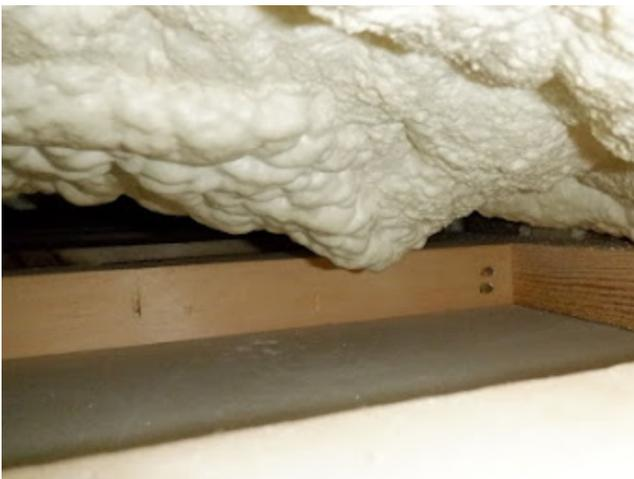
図1-6 断熱材施工により検査範囲狭小となる事例
