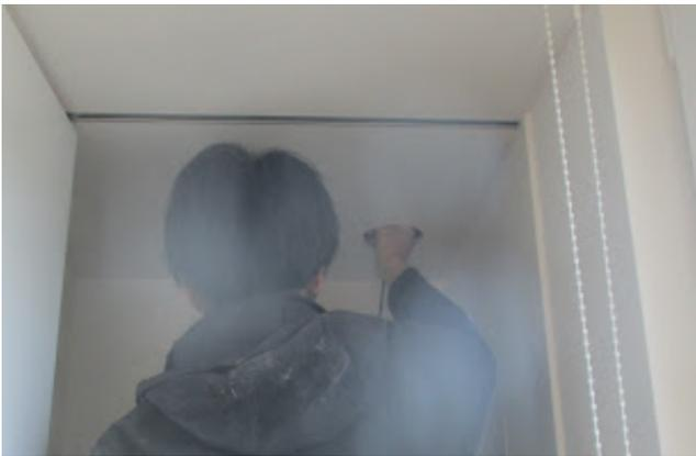
図1-5 点検口非設置のため換気口からファイバースコープによる検査を行う事例
